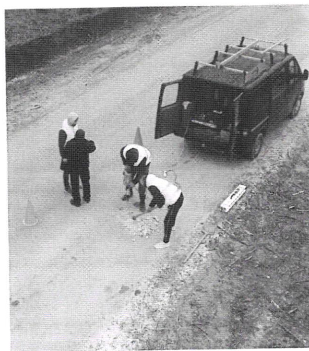
Figura 9. Executarea Șlițurilor (km 3+300)
