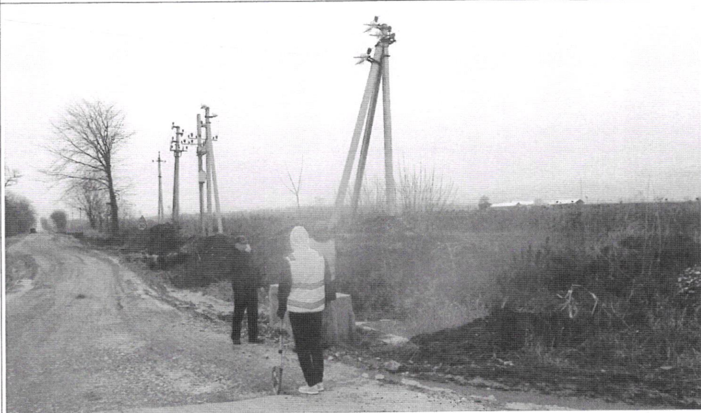
Vedere capăt amonte
