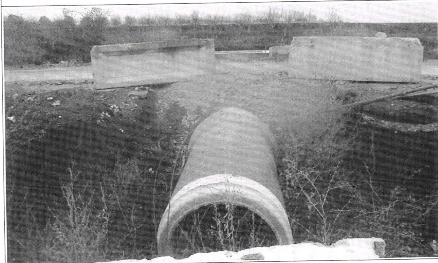
Vedere capăt aval
