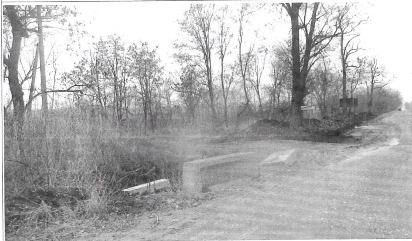
Vedere capăt aval
