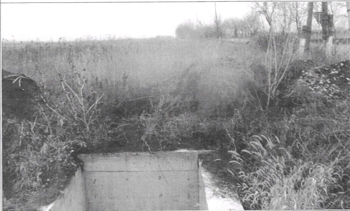
Vedere lanșaft amonte
