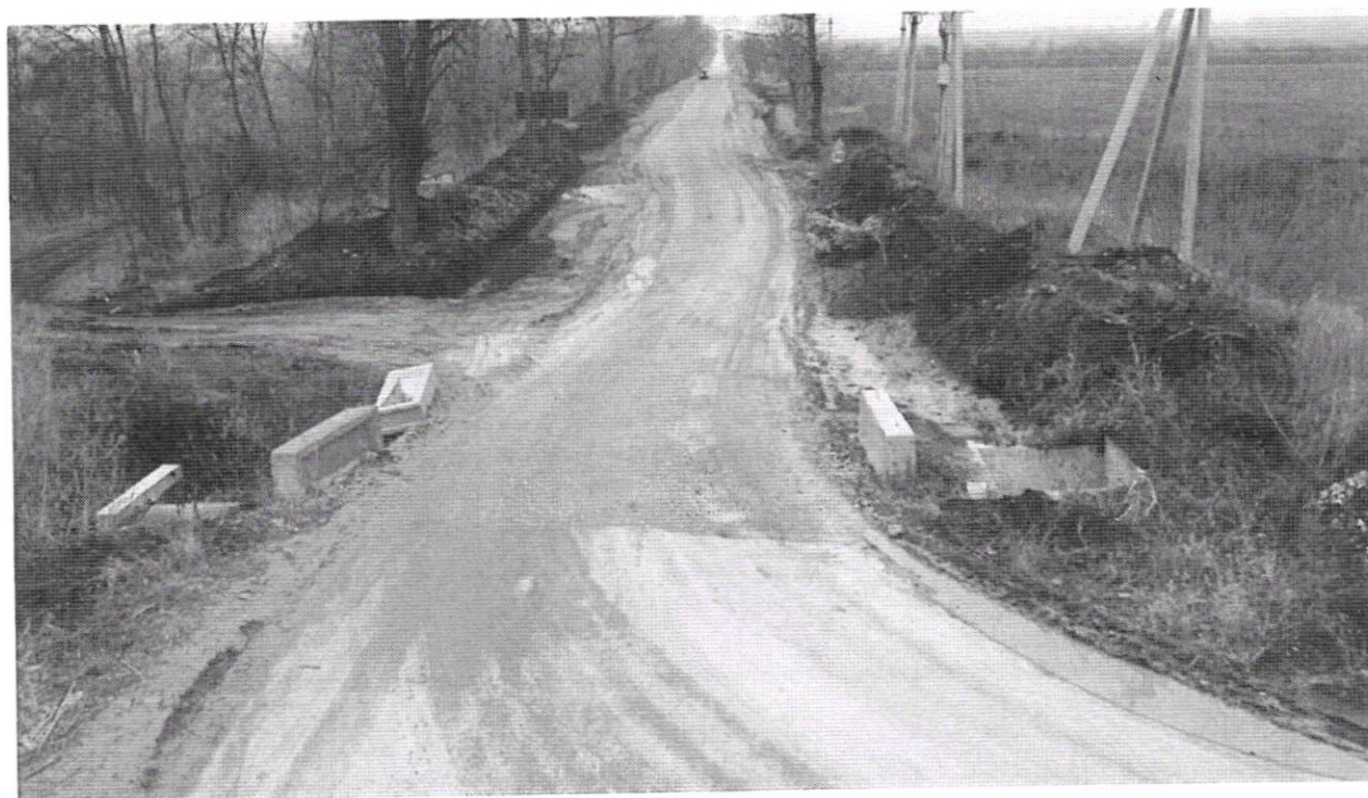
Figura 20. Drumul L103, Podețul Pc 36+70 (sens invers). Starea/Etapa executată la faza de expertiză
