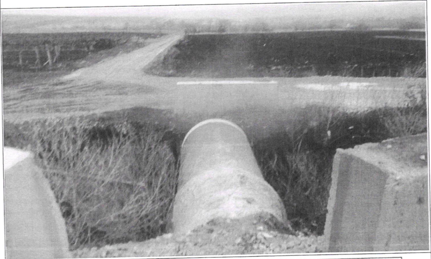
Vedere landșaft aval
