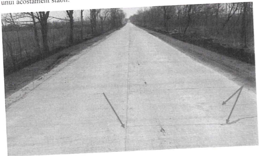
Figura 4. Km 2+640. Deschiderea rostului longitudinal (fază incipientă).
