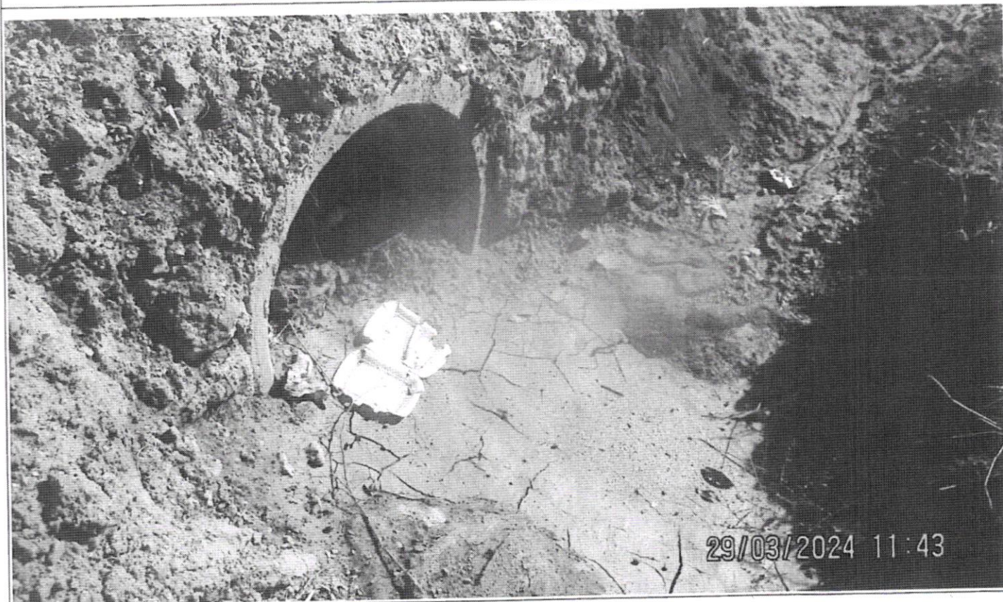
Vedere capăt amonte
