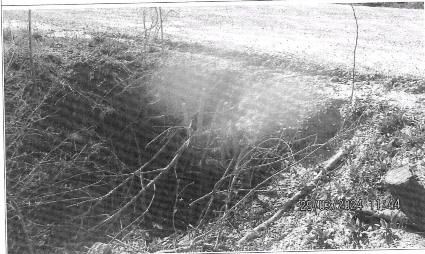
Vedere capăt aval
